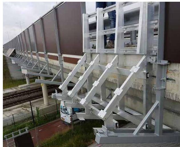
铝结构安装到钢结构上（不含A1元素）
